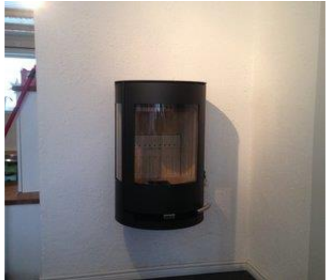
Ovan: Aduro 9-4 installerad mot murstock
