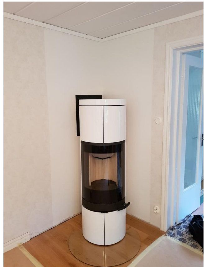
Ovan: Aduro 9-4 installerad mot murstock
