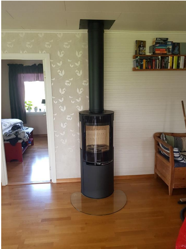
Ovan: Aduro 9-5 Lux installerad mot Biomodul-skorsten
