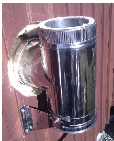
Ovan: Montering av 90 graders T-rör på fasad innan montering av genomföringsplåtar.
