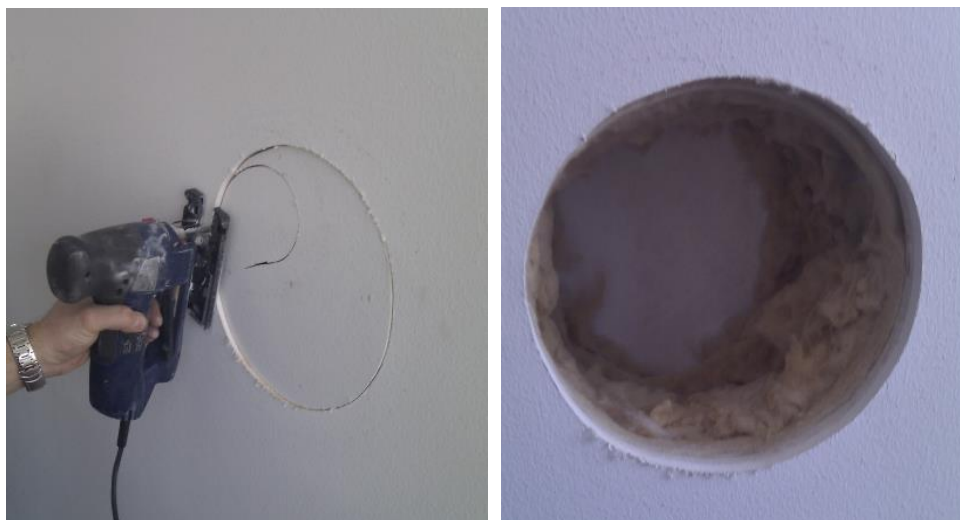
Ovan: Håltagning inför vägggenomföring
