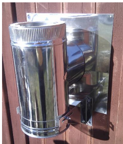
Ovan: 90 graders T-rör efter montage av genomföringsplåtar
