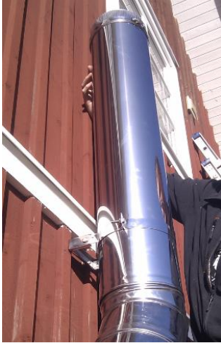
Ovan: Vägghållare monterad för att stabilisera skorstensröret
