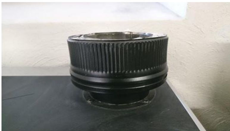
Ovan: Startadapter, med kapat innerrör, monterad på eldstadstopp.
