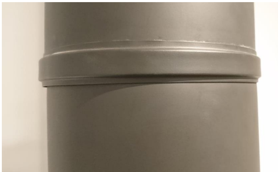
Ovan: Låsring monterad över skarv
